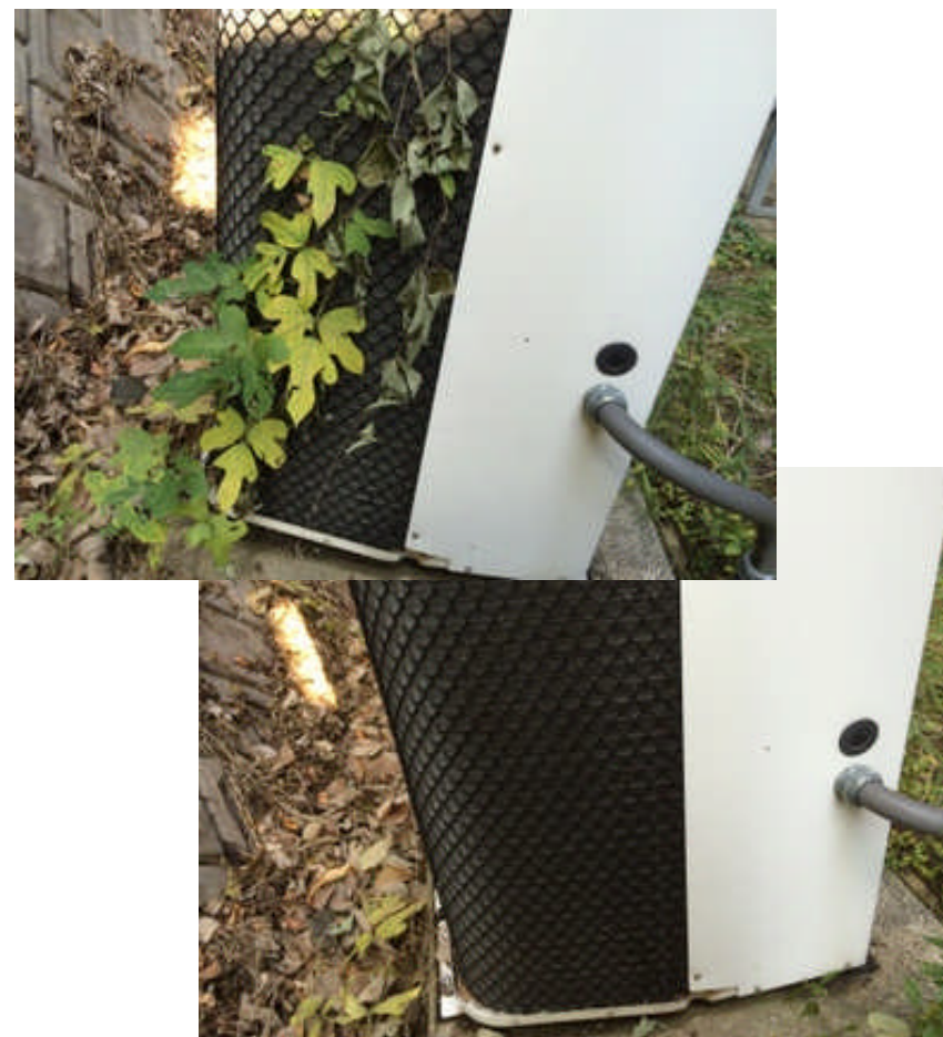
室外機草取り
