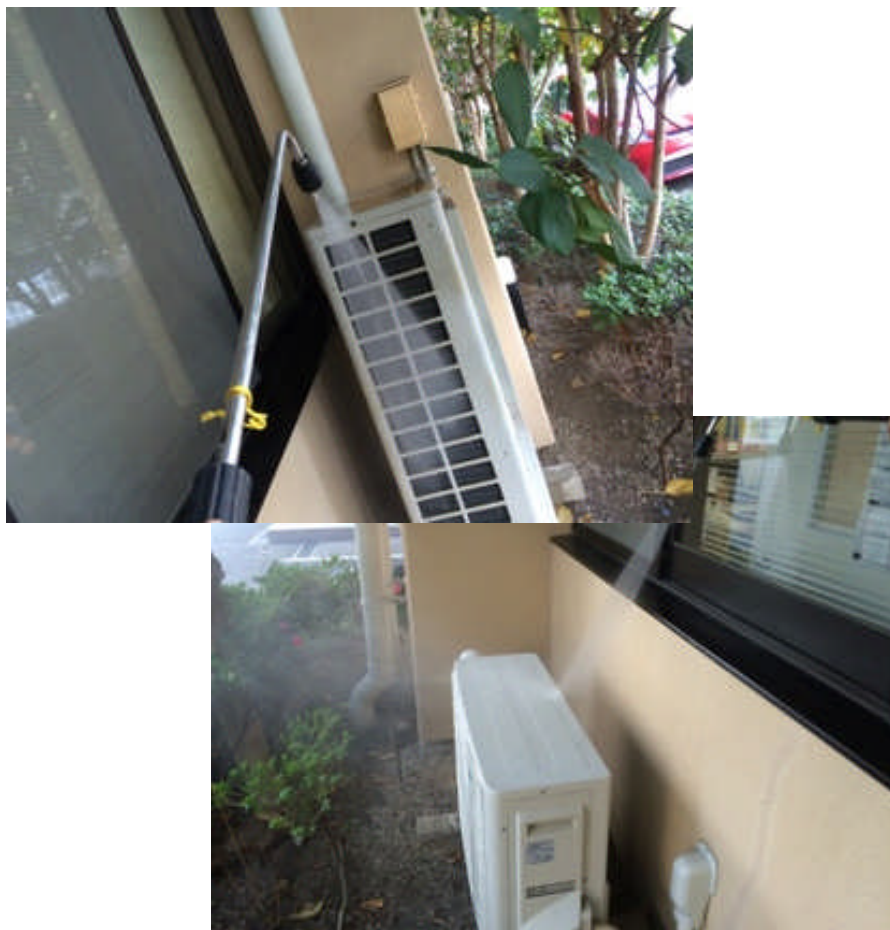
室外機高圧洗浄
